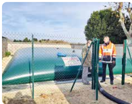
Visite de sécurité après installation d'un réservoir incendie
