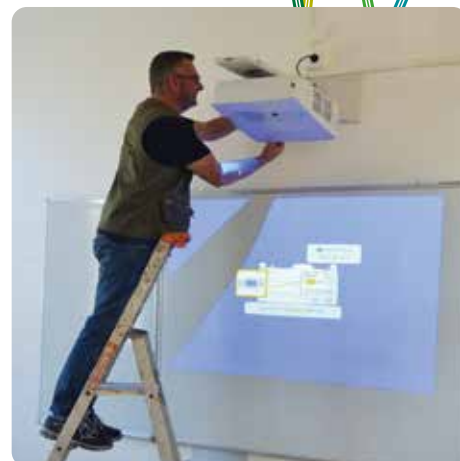
Installation d'un vidéoprojecteur à l'école Pierre Loti
