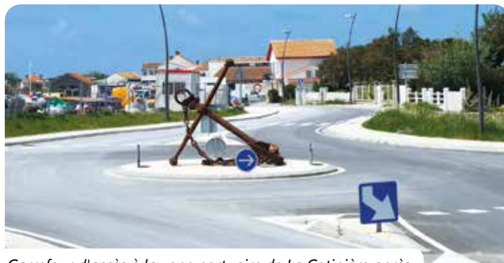
Carrefour d'accès à la zone portuaire de La Cotinière après
